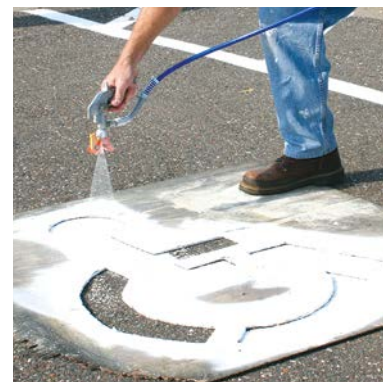
Нанесение разметки с помощью трафарета
